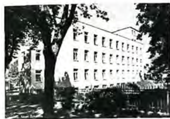
Moss sykehus før ombygningen – og samme bygning i ny og helt forandret utgave.
