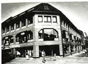
Nye bygninger i handelsbyen Moss: Brekkegården i Dronningens gate og Piasenteret.
