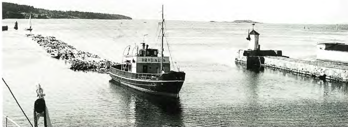
Slepebåten Høvdingen kommer sørfra inn i Kanalen med tømmer til Cellulosefabrikken på slep.
