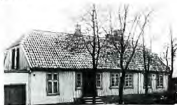
Hus i senempirestil: Dette halv-annenetasjes trehuset på Radet, som etter hvert ble omdøpt til Klostergaten, ble bygget i 1820 og var karakteristisk for byggeskikken i første halvdel av 1800-tallet.
