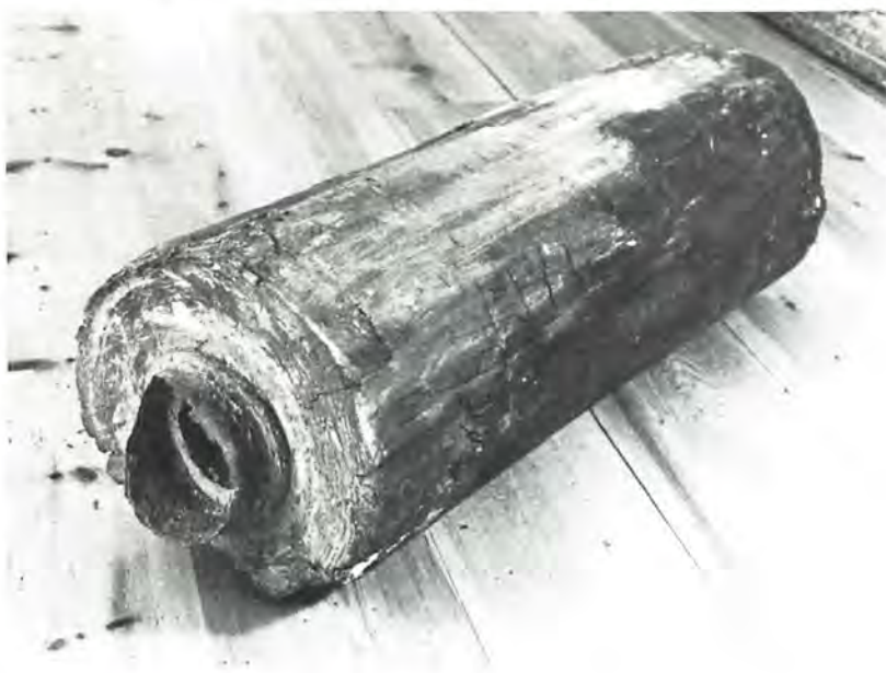
Vannrør av tre som ble brukt fra Mossefossen og ned til vannpostene i byen. Legg merke til koblingsmekanismen ved enden av det ut-hulle treerøret. Mannen som laget slike, ble kalt «postmager». Ingen steder som lå høyere enn vannspeilet, kunne selvsagt få vannpost.
